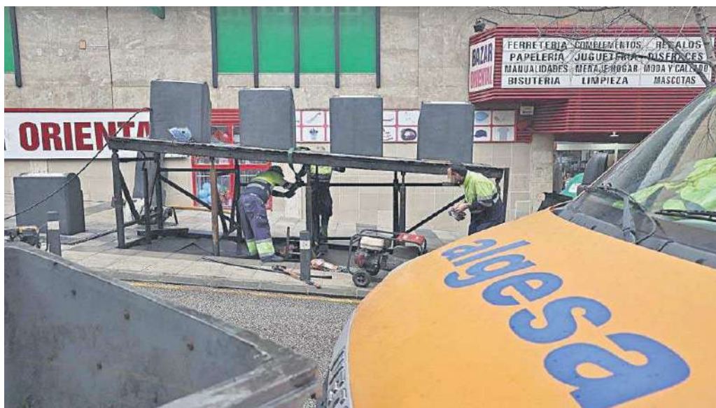
Trabajadores de Algesa reparan la plataforma de unos contenedores soterrados en la calle Trafalgar.
